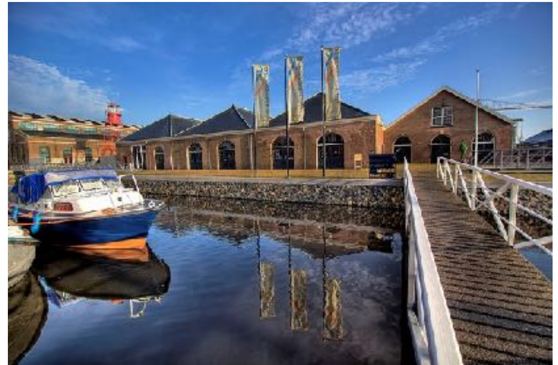
Gebouw 66 krijgt de baliefuncties en de raadzaal
